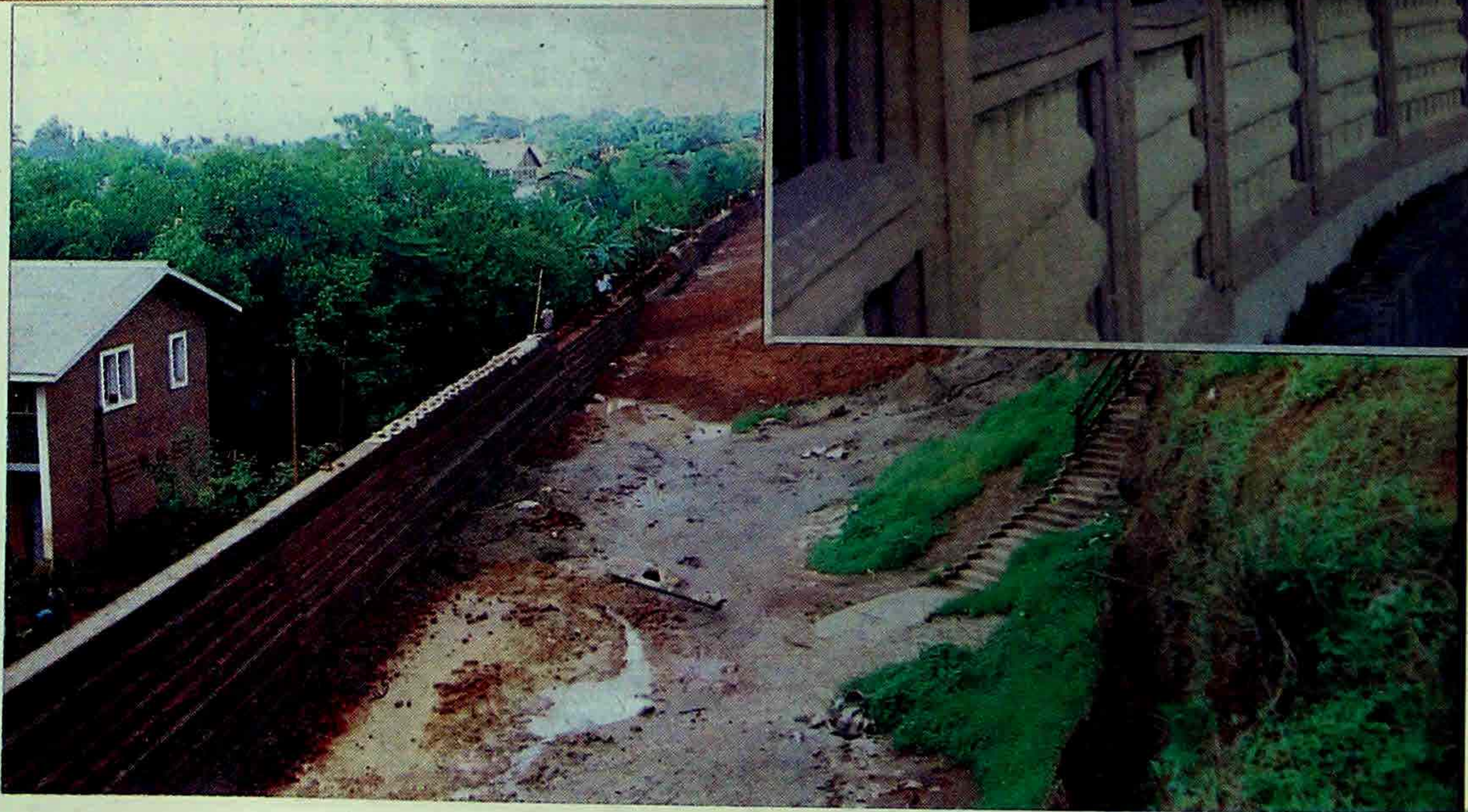
စေတီတော်အဝင်လမ်း တည်ဆောက်မှုအခြေအနေနှင့် မြေထိန်းနံရံလုပ်ငန်း ဆောင်ရွက်မှုအခြေအနေ
